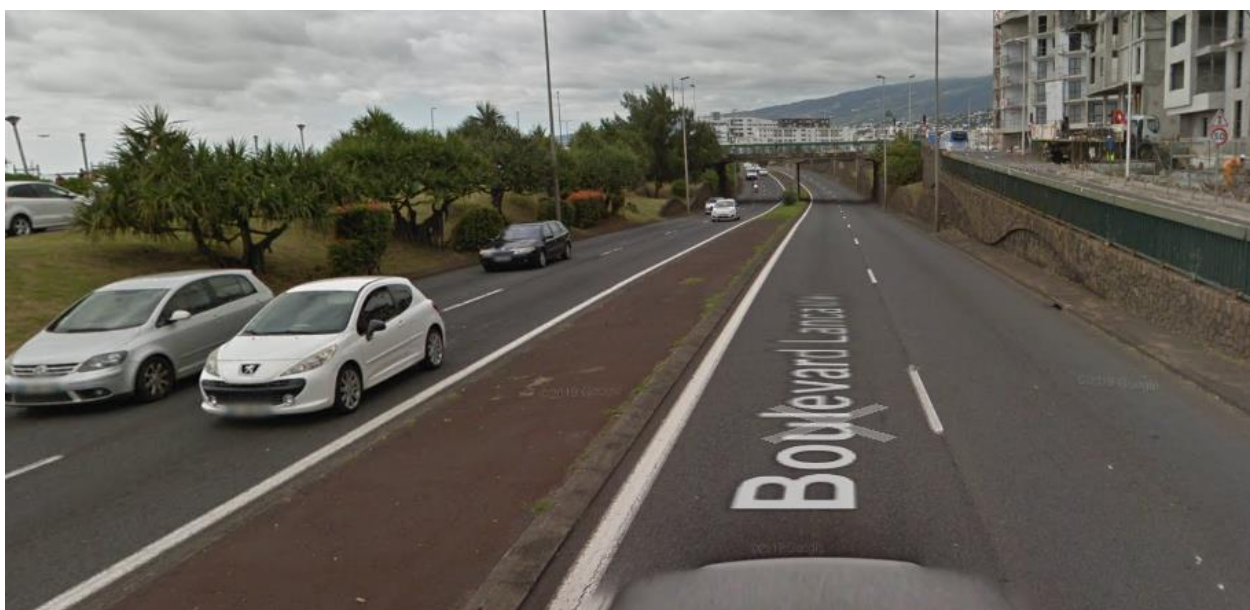
Circulation en décaissé sous un pont sur le boulevard LANCASTEL
