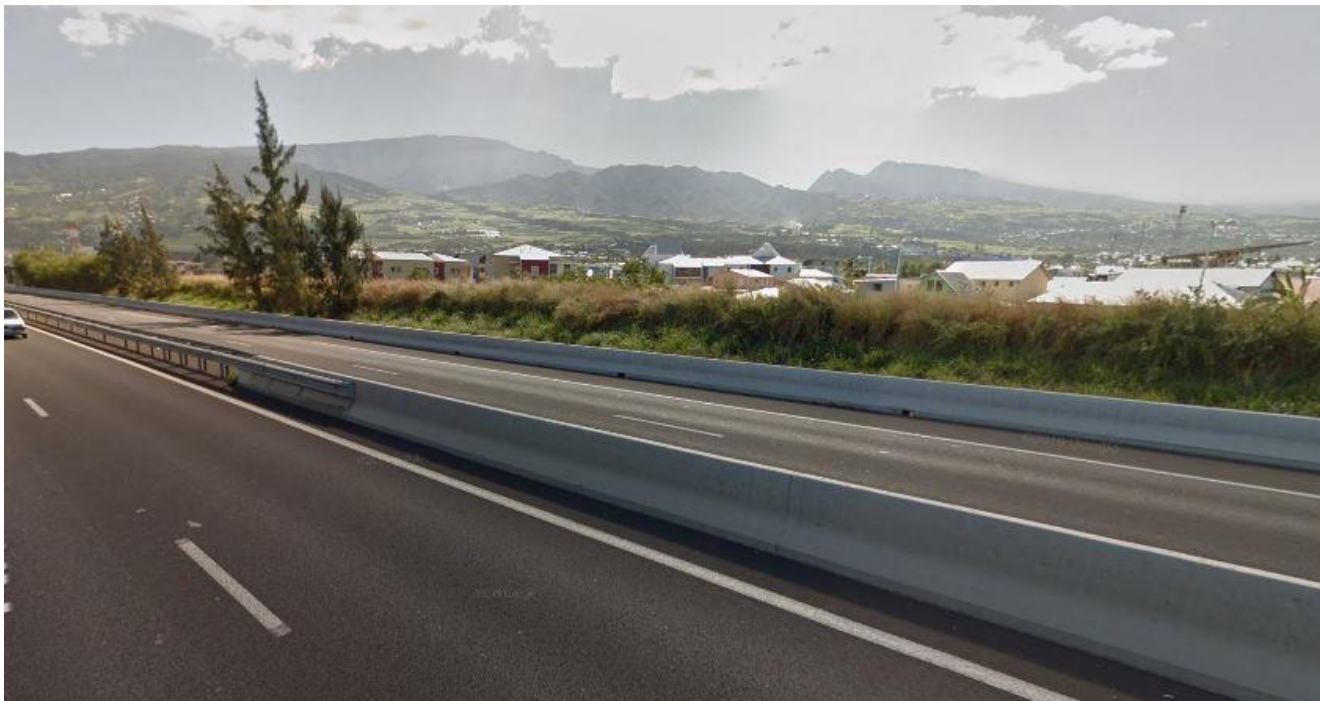
Protection des logements du bruit routier de la RN1 à l'aide d'un merlon à Saint-Louis
