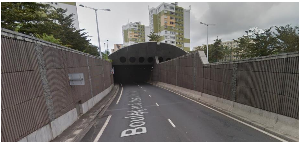
Circulation en tranchée couverte sur le boulevard Sud
