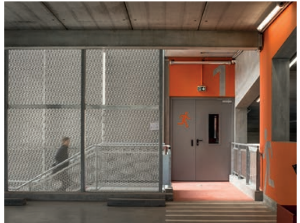
Référence du parking-silo de la Plaine Images à Roubaix par DE ALZUA +
