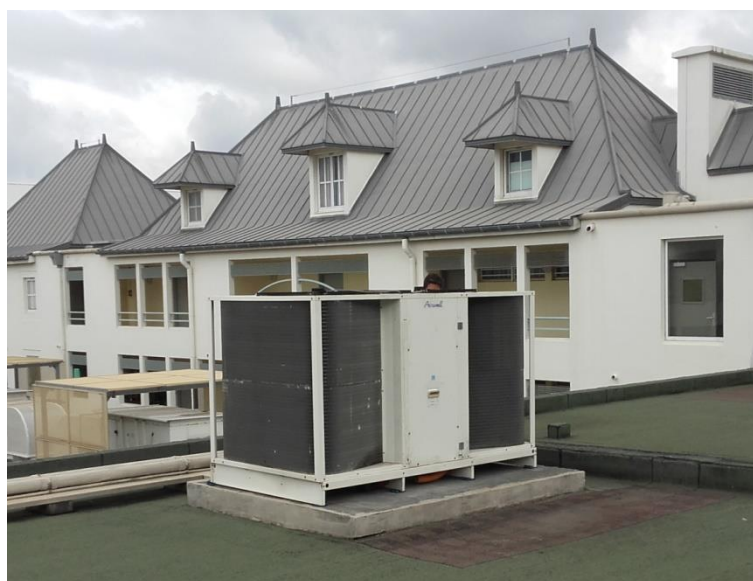
Exemple d'un condenseur d'air bruyant d'un magasin de la rue Maréchal Leclerc à Saint-Denis
