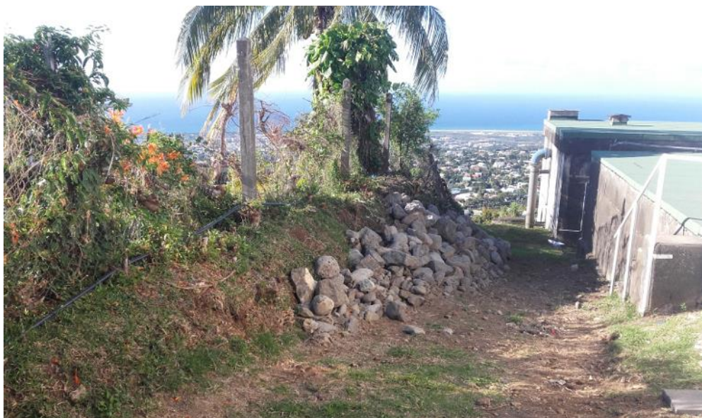
Vue du local de pompage de la station de LA BRETAGNE et du terrain du riverain
