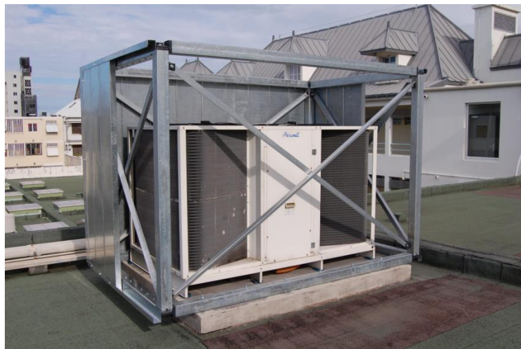
Traitement d'un condenseur par des écrans acoustiques
