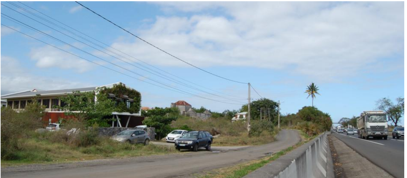
Bâtiment à ventilation naturelle traversante implanté en bord de RN2
