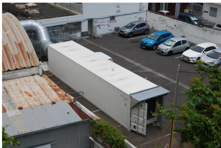
Caisson de silencieux mis en place pour traiter un extracteur bruyant
