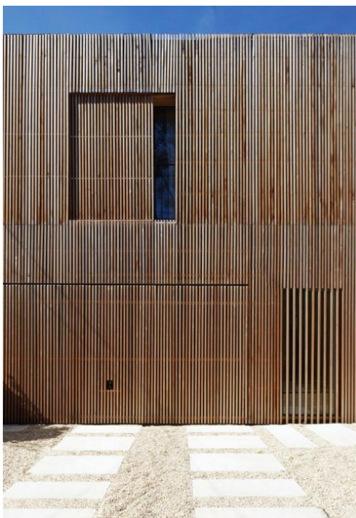
Façade munie d'une protection en claustras de bois
