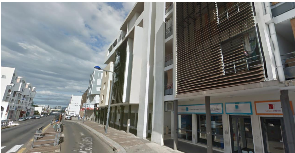
Façades dotées de brise soleil rue maréchal LECLERC à SAINT DENIS
