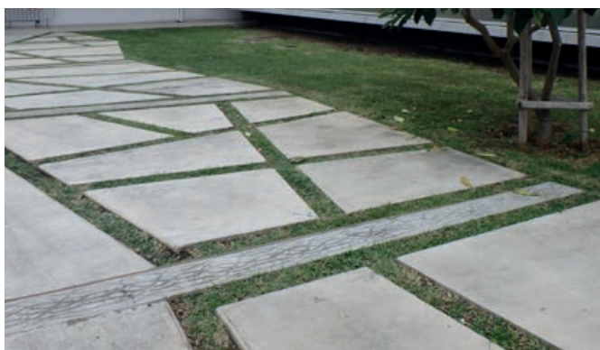
Des dalles béton avec joints enherbés pour les cheminements piétons
